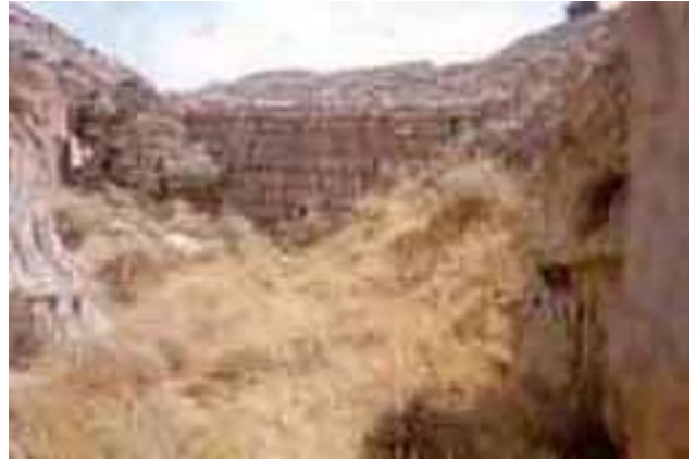
2.- Azud, de cuatro metros de altura por seis de ancho, aterrado, cada piedra pesa alrededor de 1.000 kilos. La fecha de su construcción puede situarse en la primera mitad del siglo XIX.
