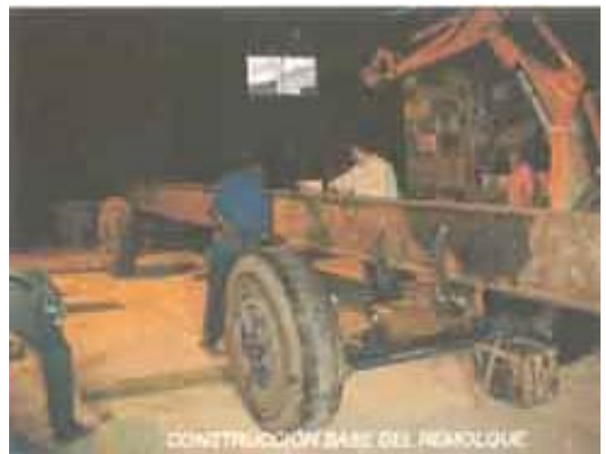
CONSTRUCCIÓN BASE DEL REMOLQUE
